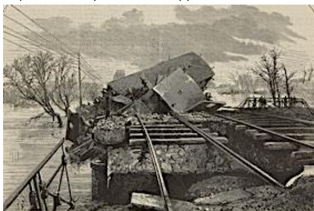
Rupture du pont de Lutterbach sur la Doller Aspect de la première arche
