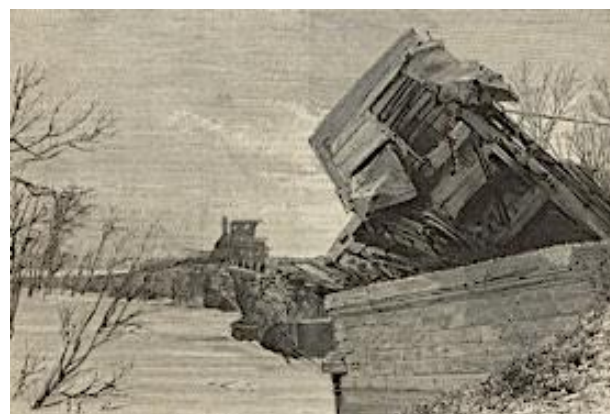
La rupture du pont de Lutterbach Aspect de la seconde arche après l'accident
