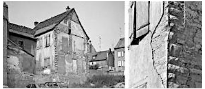
La « maison forte » avant sa démolition (Doc. « Inventaire du patrimoine en Alsace »)
