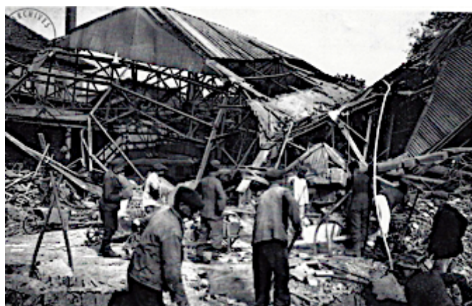
Opérations de déblaiement
